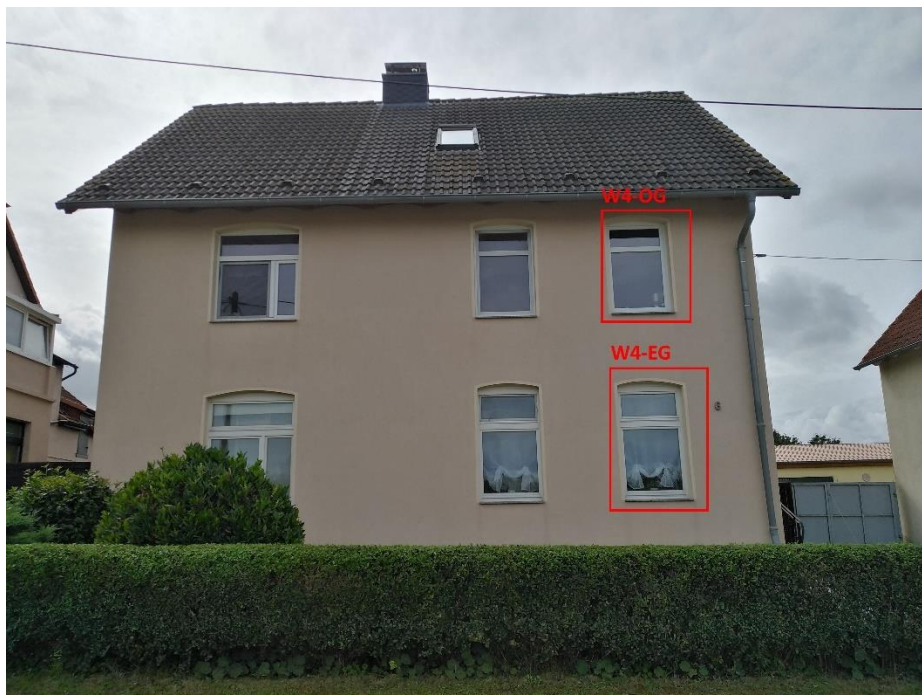
Bild 8: Wohnhaus Glashäger Straße 6 mit Immissionsflächen W4-EG und W4-OG
