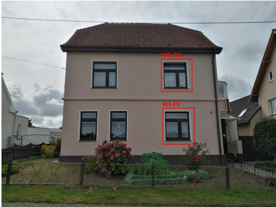
Bild 7: Wohnhaus Glashäger Straße 5 mit Immissionsflächen W3-EG und W3-OG
