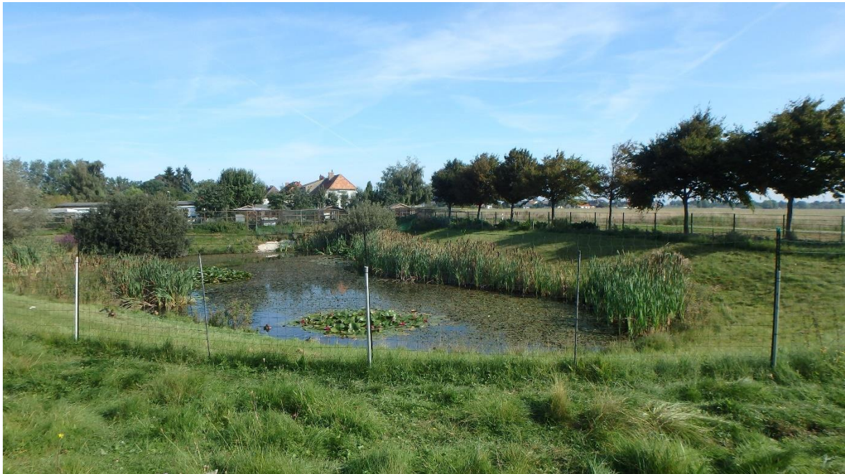
Naturnah gestaltetes Regenrückhaltebecken südlich der Ergänzungsflächen.
