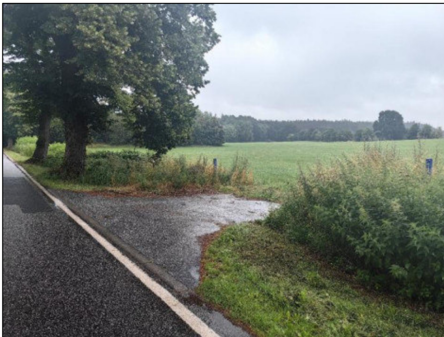
Abb. 11: Asphaltierte Ackerzufahrt ins nördliche Plangebiet (Foto 04.07.2024).
